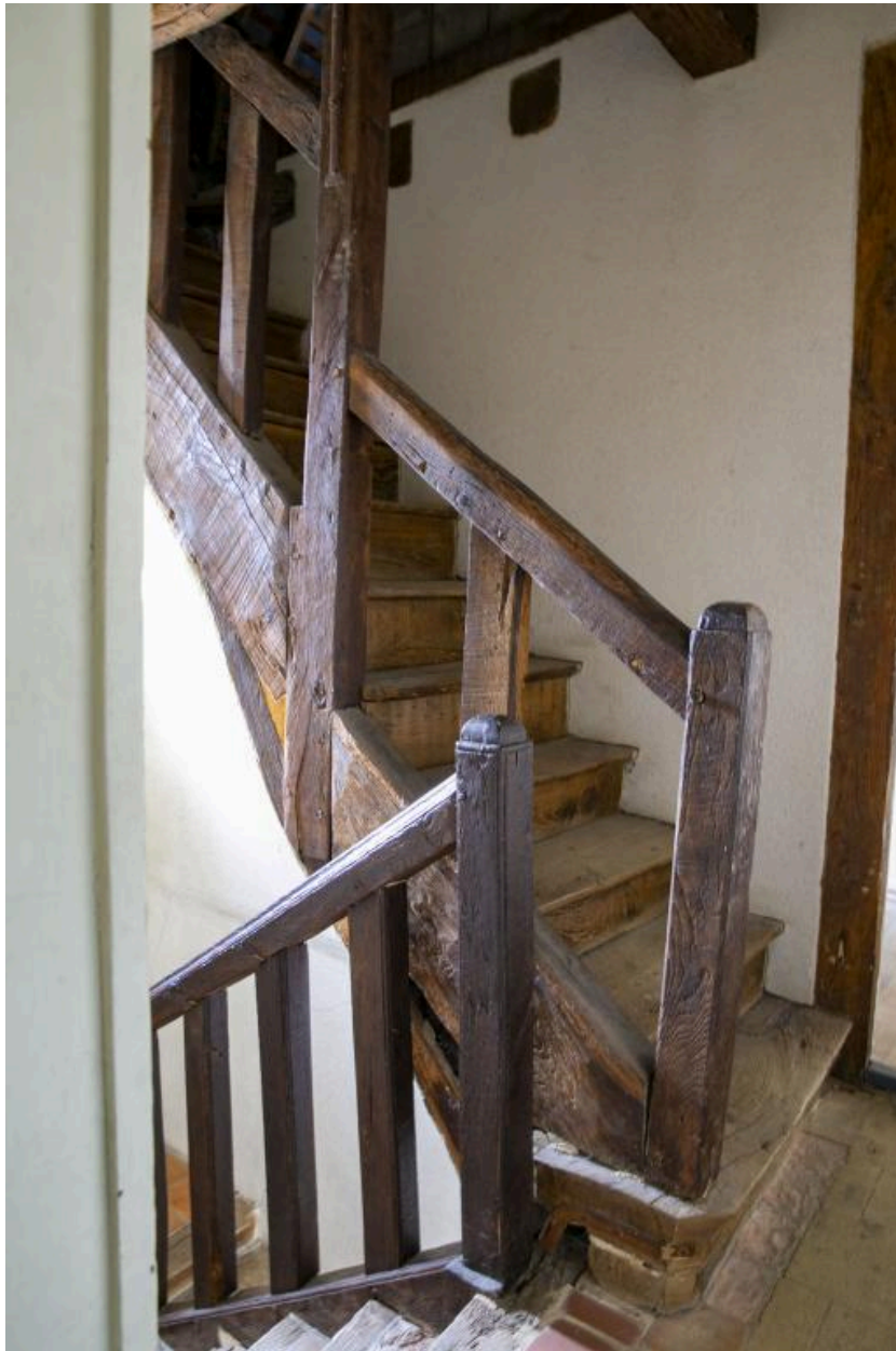
L'escalier au palier du rez-de-chaussée.
