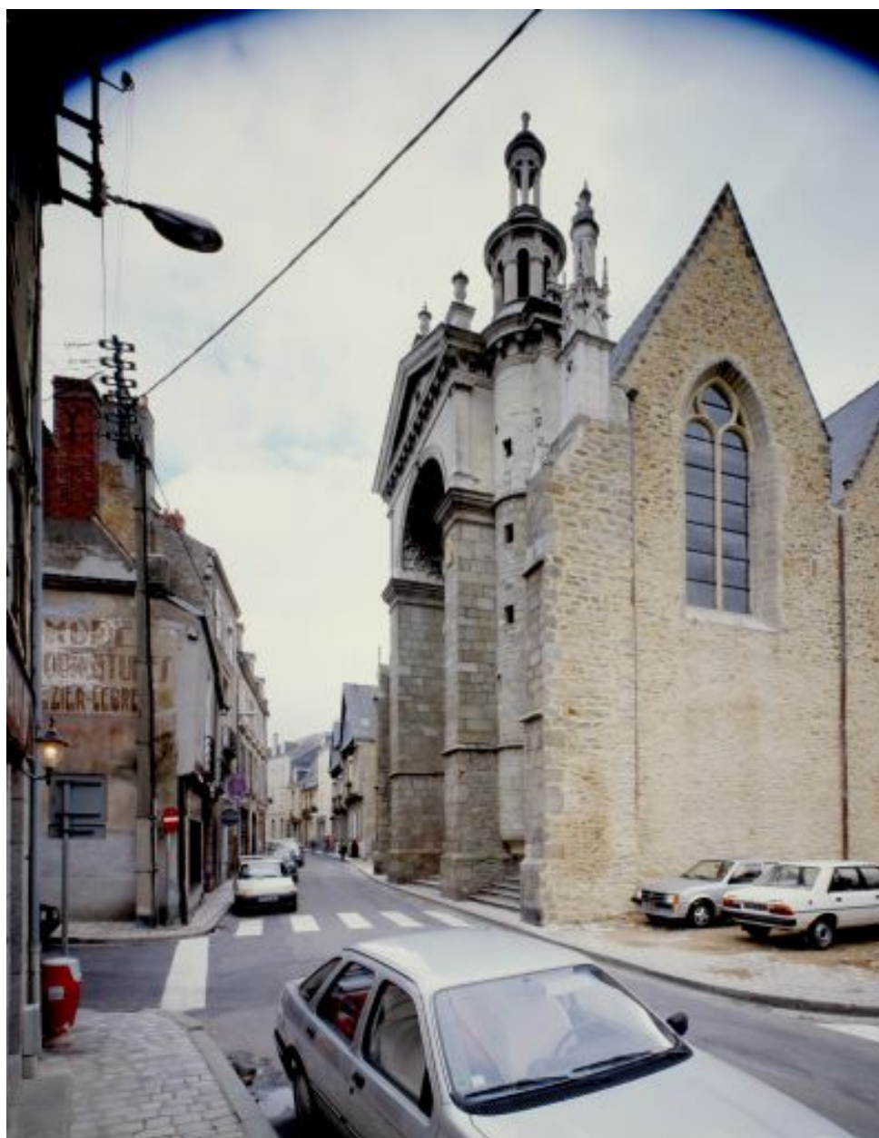
Elévation antérieure et première travée de la nef : vue d'ensemble depuis l'est.
