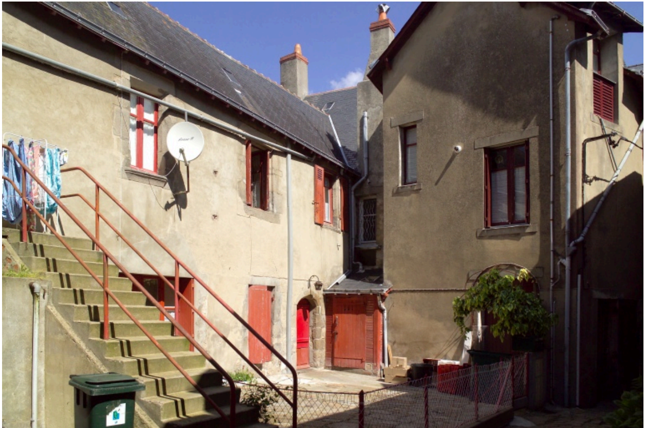
Vue de la façade sud.
