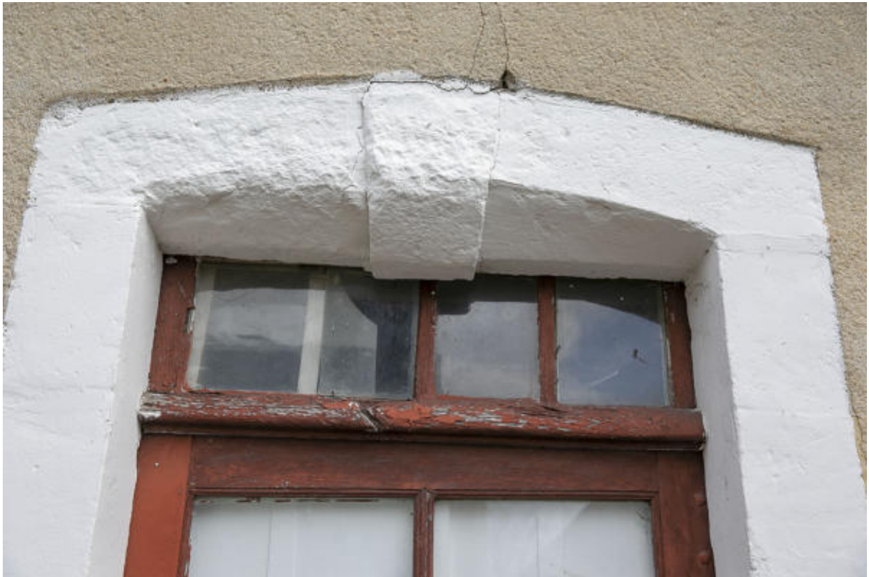
Une porte en arc segmentaire délardé du XVIIIe siècle, rue du Château.
