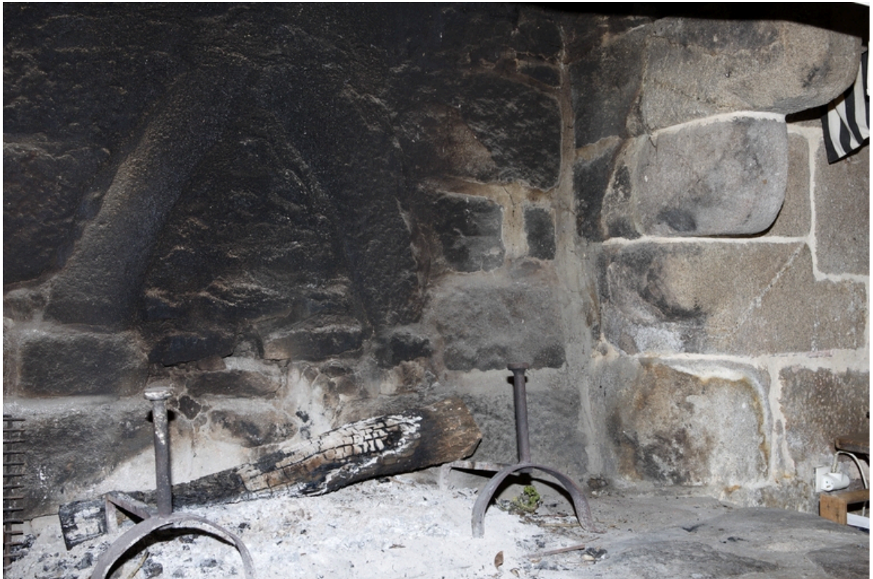
Rez-de-chaussée. Salle basse. Détail du piédroit de droite de la cheminée.
