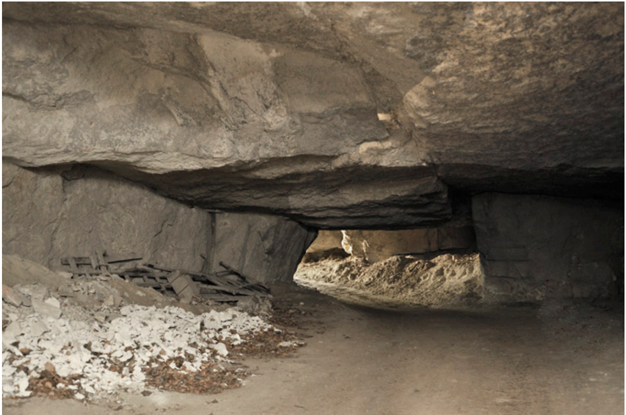
Site principal (11-16, ruelle des Perreyeurs). Galerie d'extraction de la carrière.
