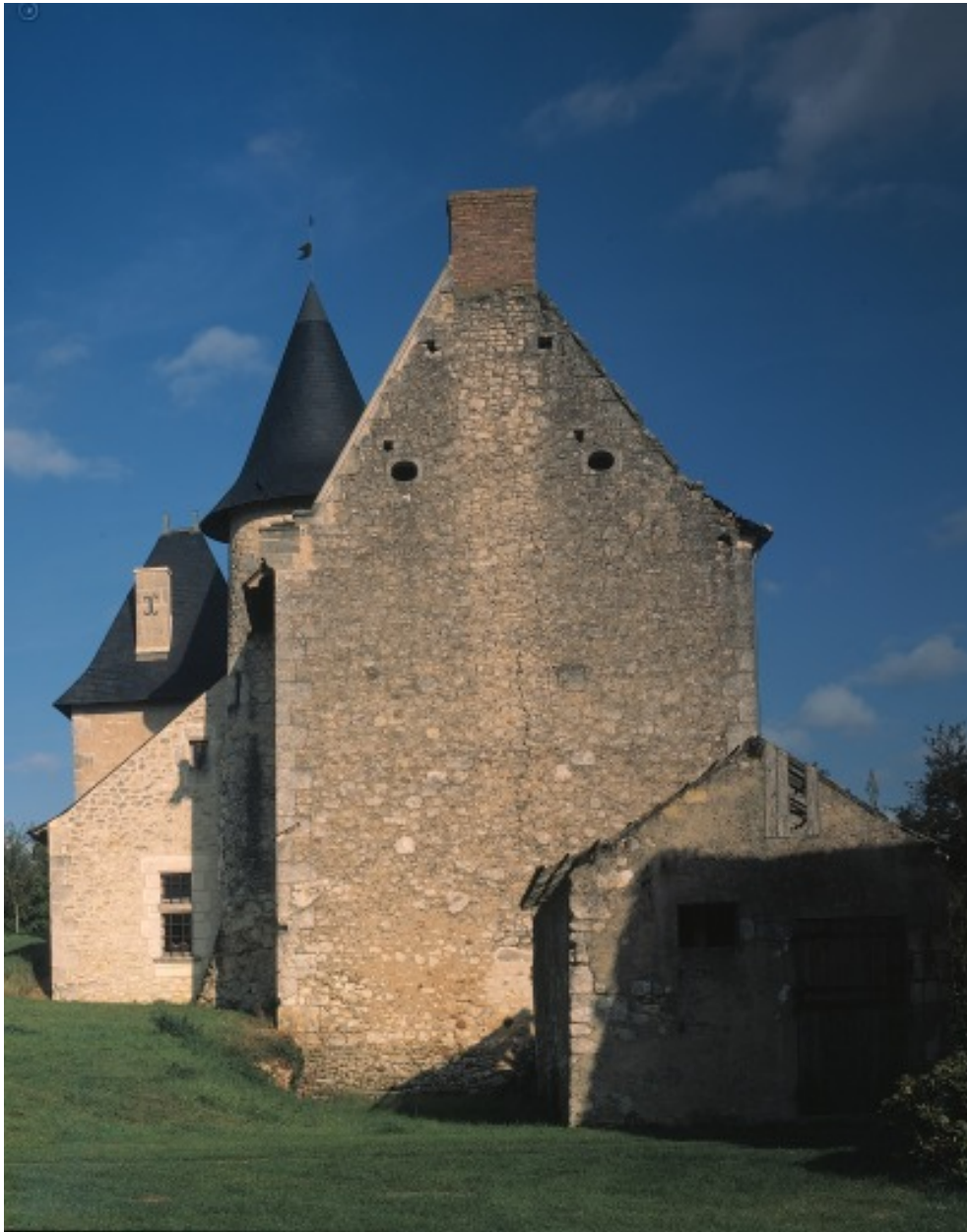
Pignon ouest du logis.
