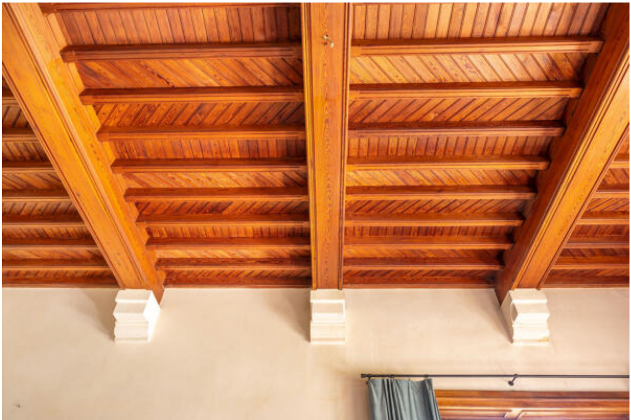
Le plafond du grand salon.
