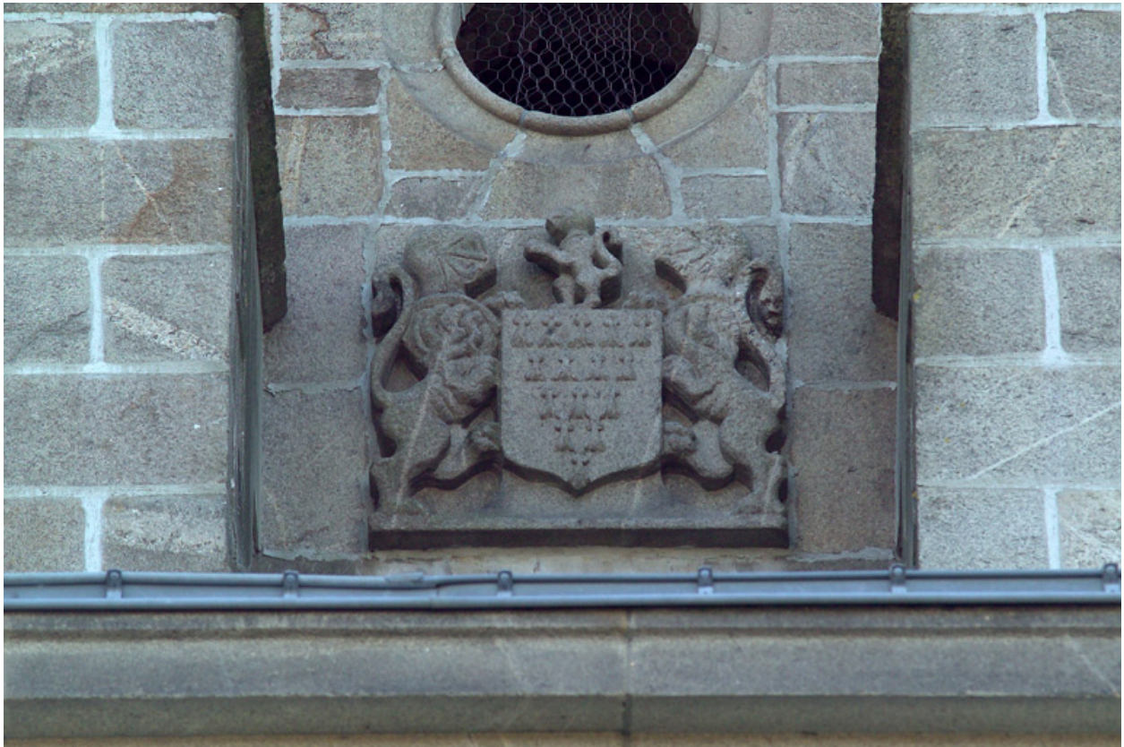
Face nord du campanile, détail du blason.
