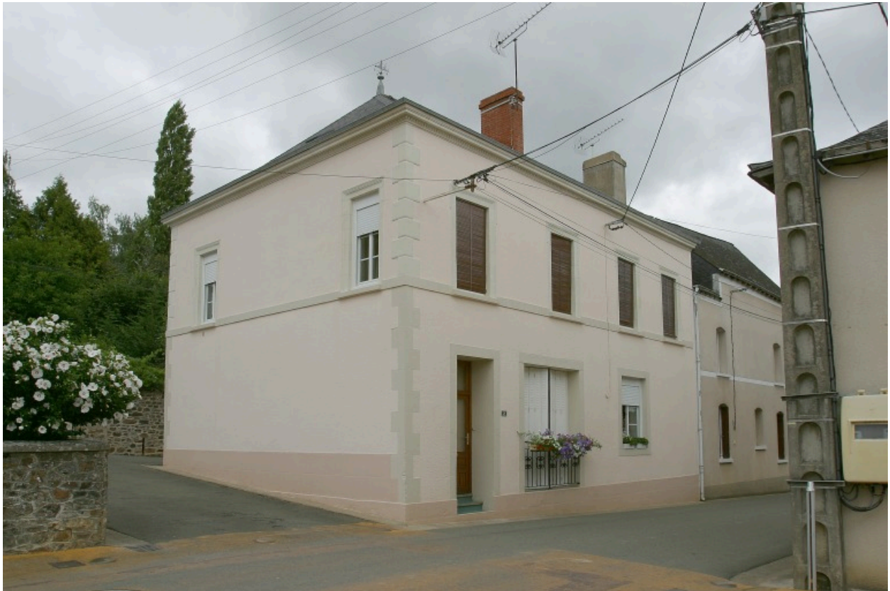
La façade principale donnant sur la route de Saint-Pierre à l'est et l'élévation sud.
