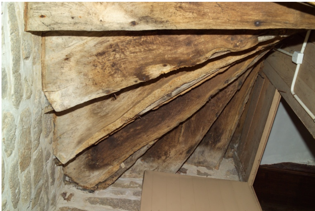
Vue des marches de l'escalier entre la cave et le rez-de-chaussée.
