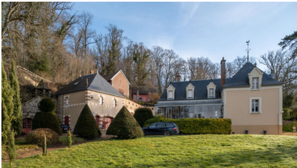
Le logis et ses dépendances : vue d'ensemble.
