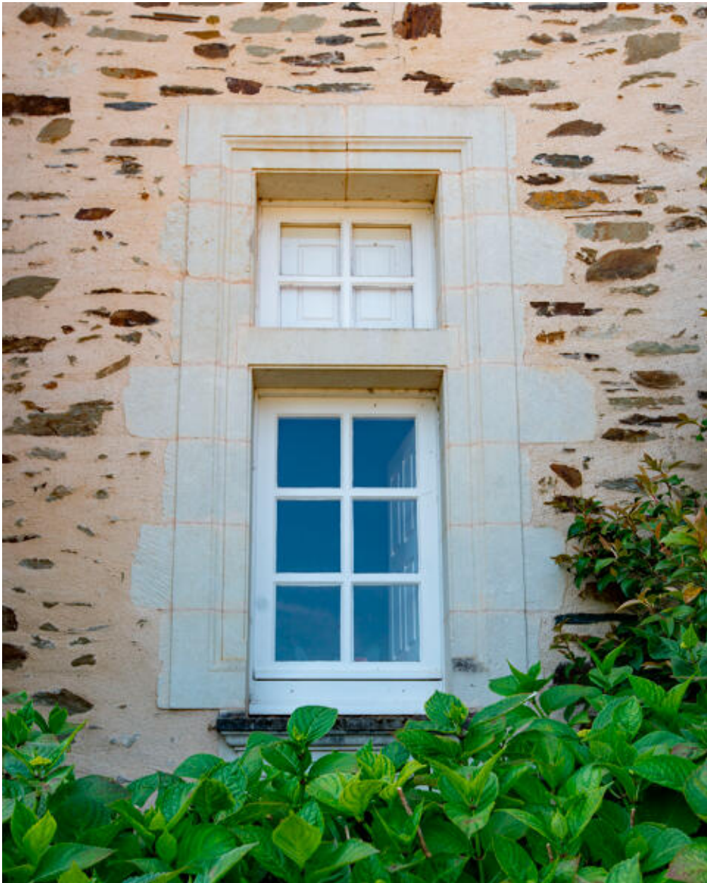
Une fenêtre de la façade antérieure.
