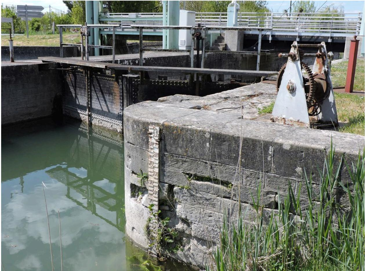
Règle de niveau d'eau sur la culée de tête amont de l'écluse, rive droite.
