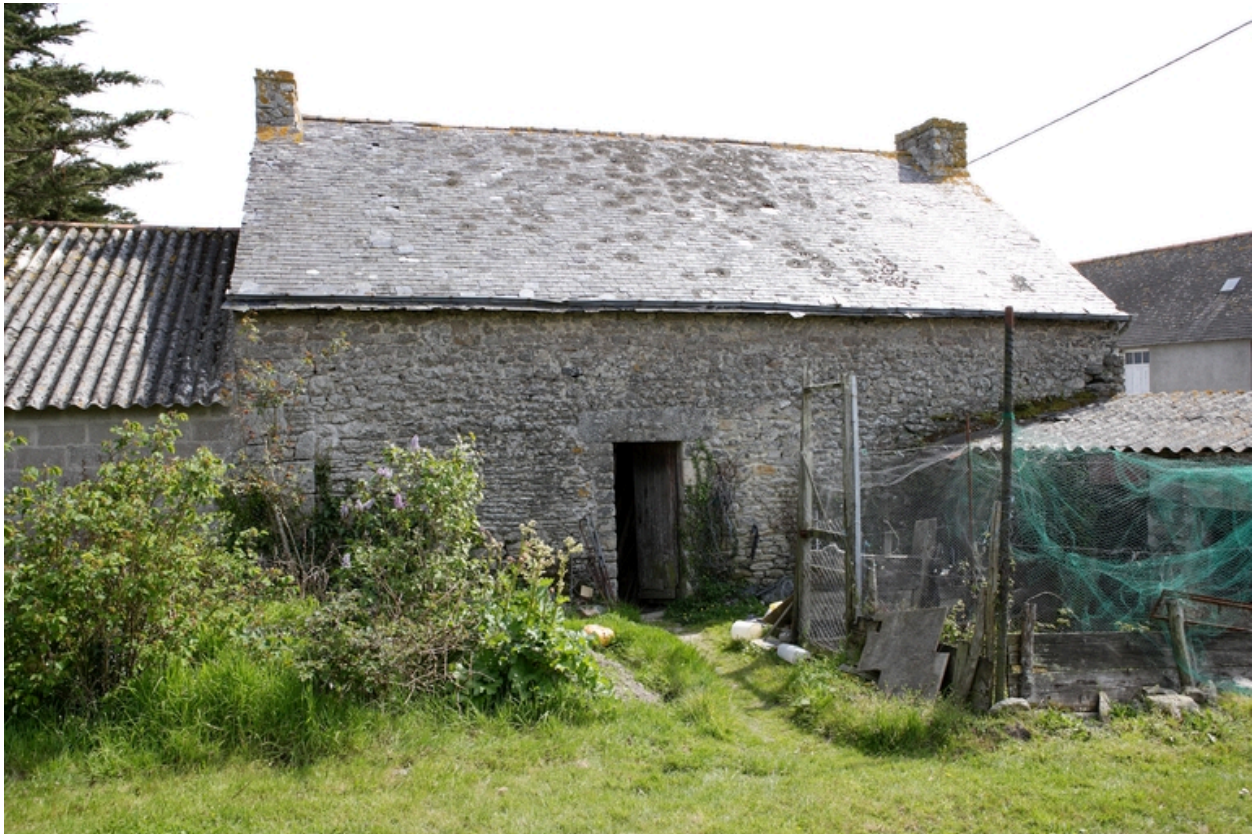
Vue de la façade ouest.
