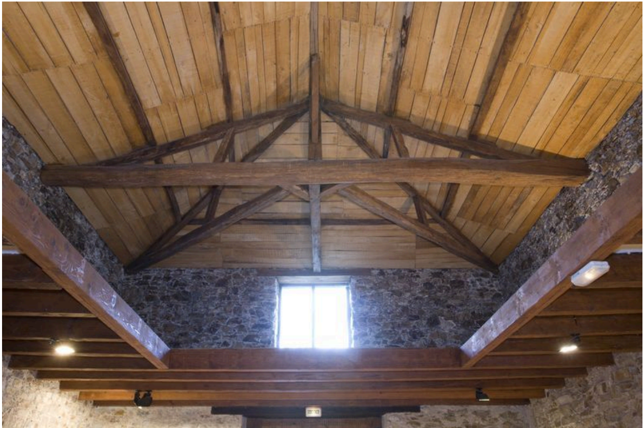
L'ancienne écurie : détail de la charpente.
