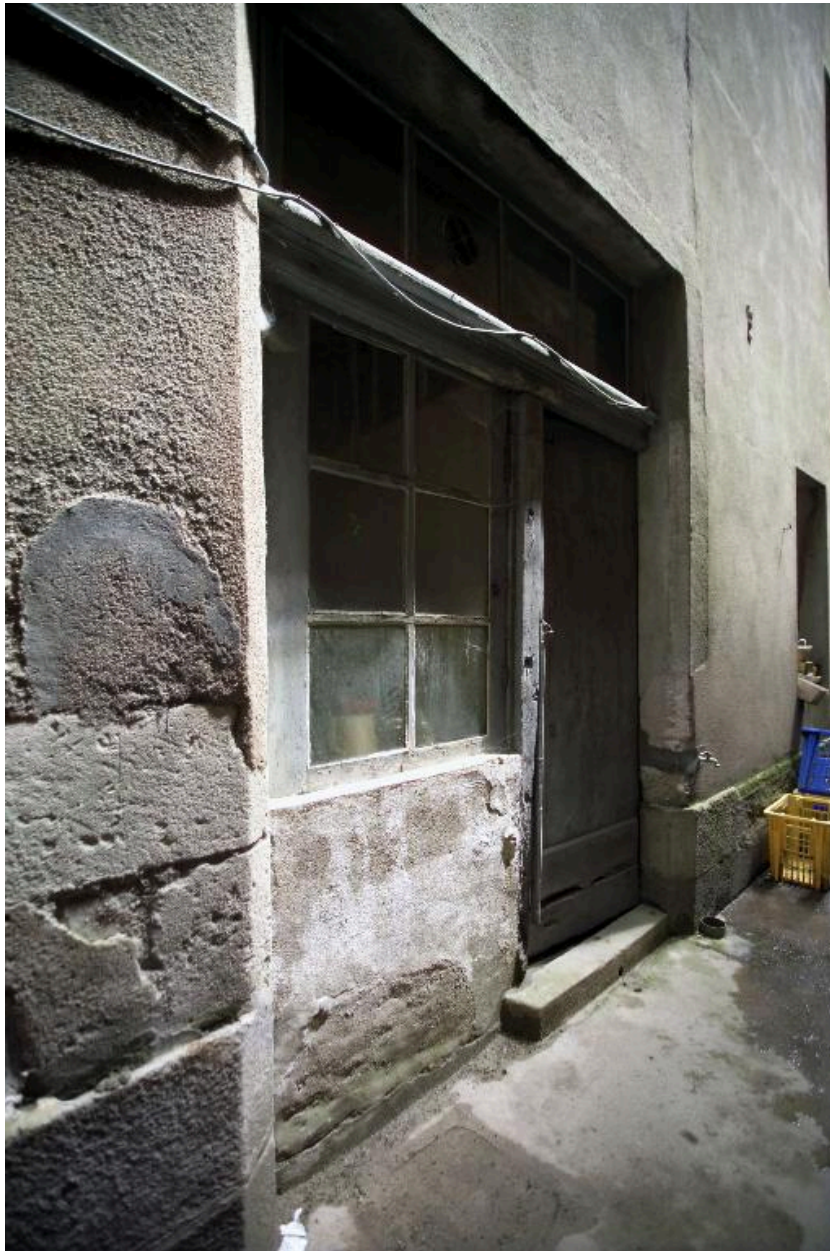
La porte d'accès à l'escalier depuis l'allée.
