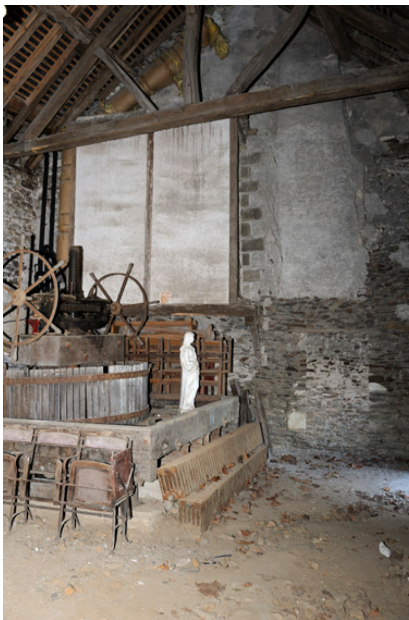
Intérieur du cellier. Pressoir en bois.
