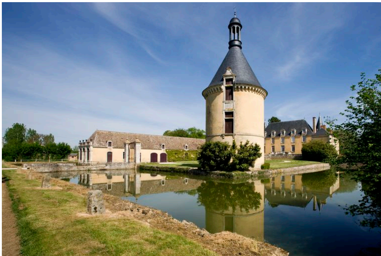
Douves de la basse-cour.
