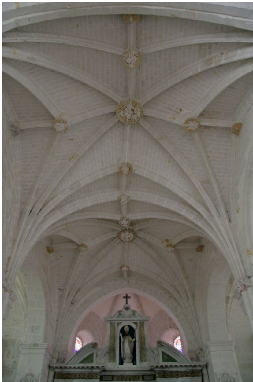
Couvrement du chœur en voûte de type angevin.
