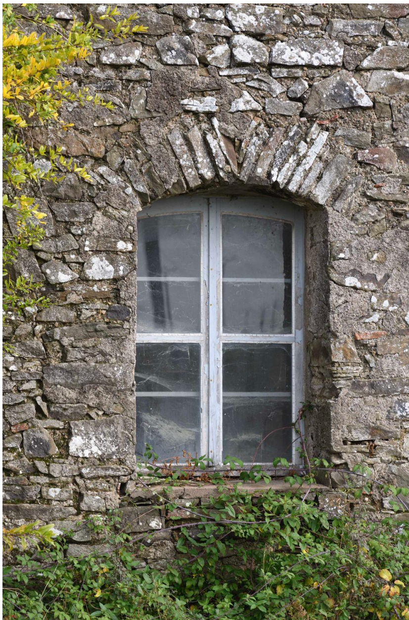
Détail d'une baie en moellons de micaschiste, bâtiment ouest.
