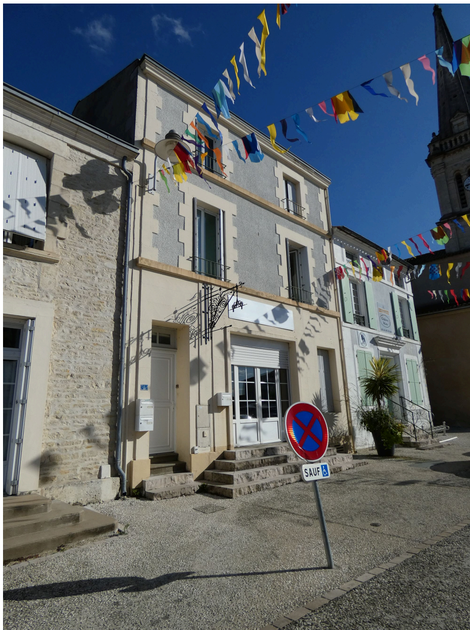
La maison vue depuis le nord-ouest.
