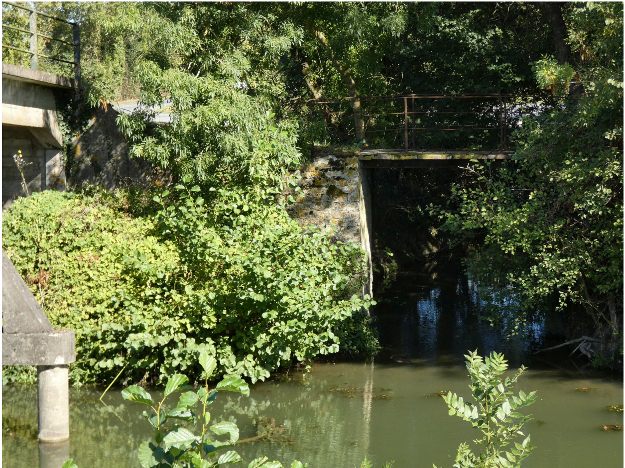
La passerelle de halage à l'entrée du port, vue depuis l'ouest.
