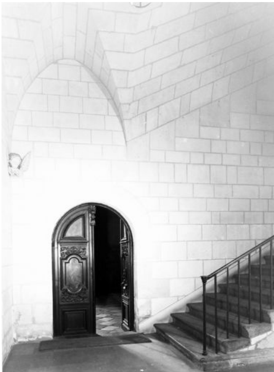
Abbaye, vestibule de l'aile orientale, face sud. Départ de l'escalier (dit des matines) et porte vers la sacristie.
