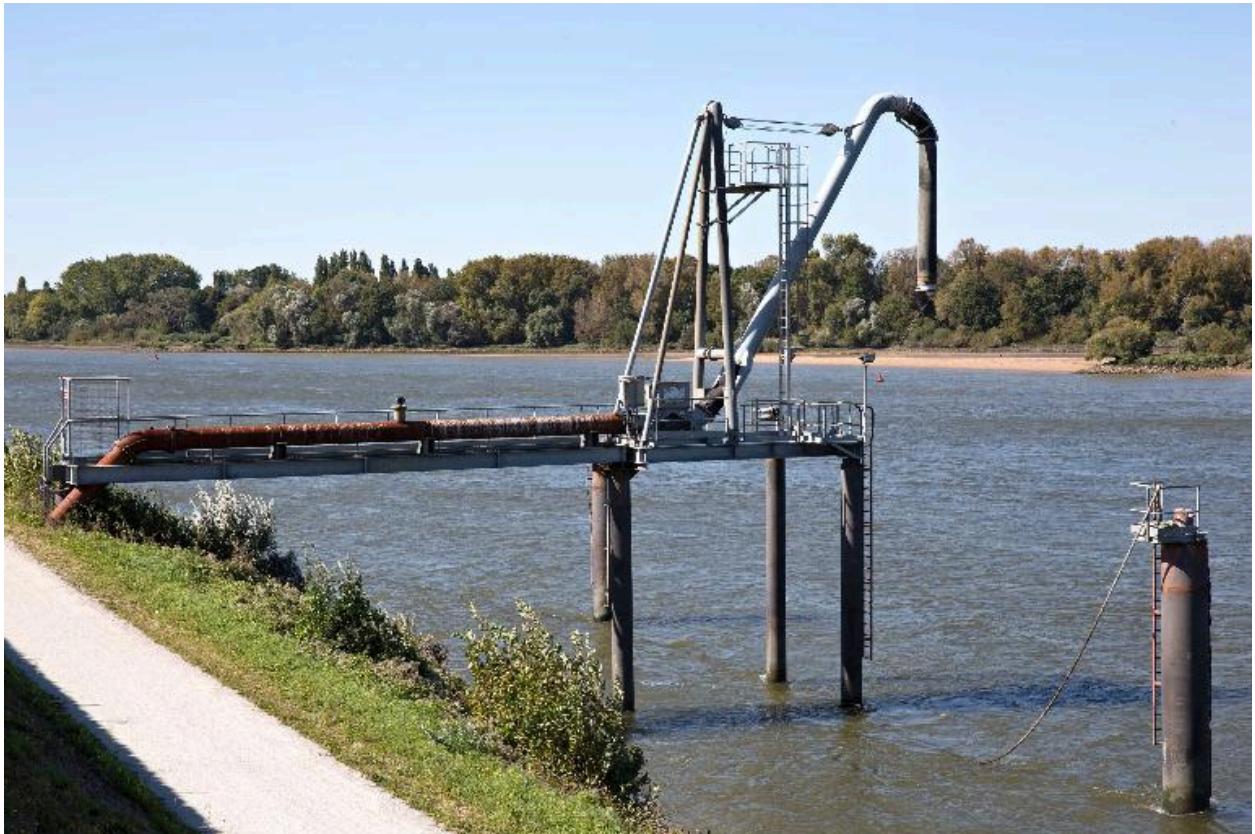
Appontement de déchargement.
