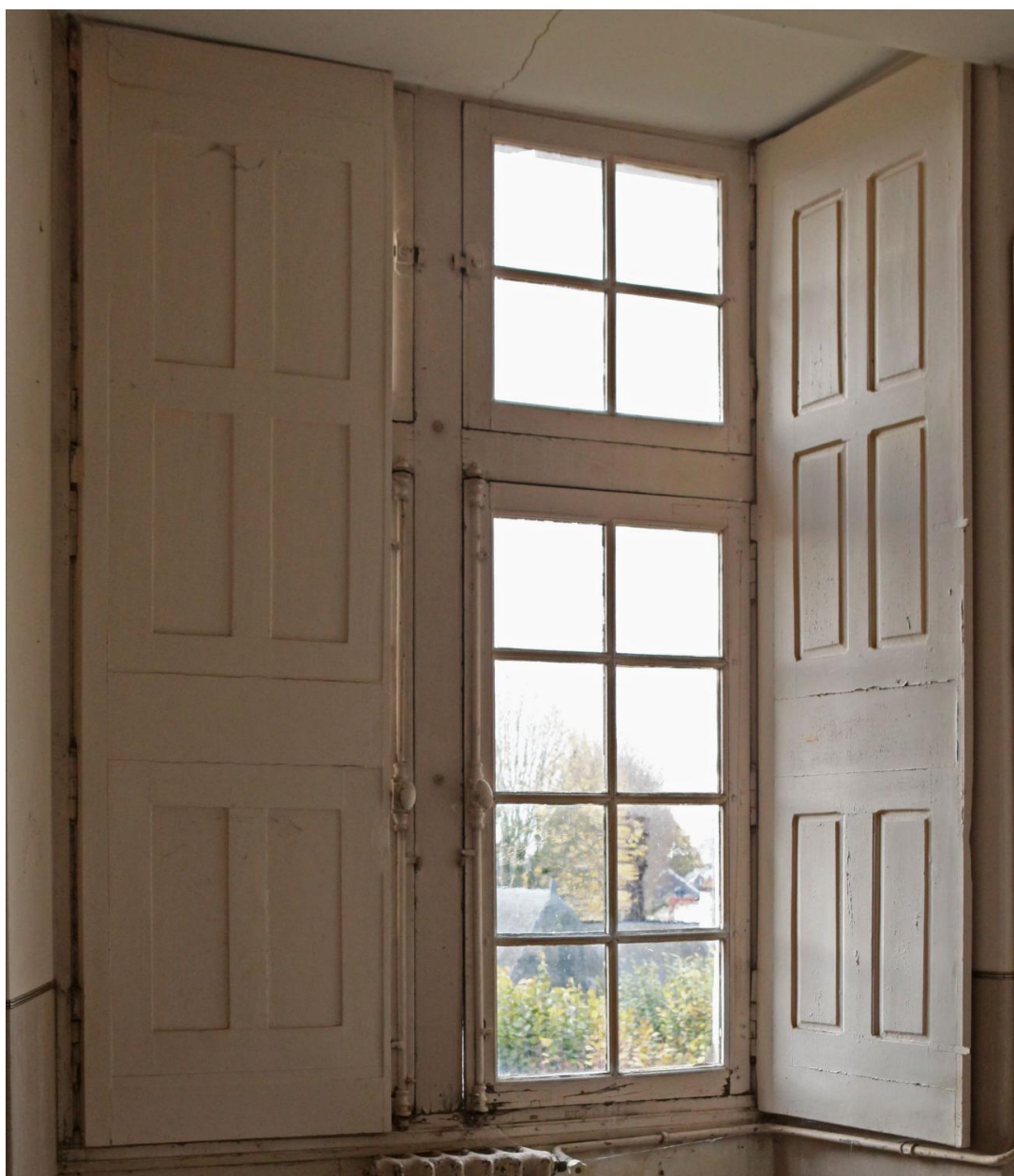
Bâtiment principal, 1er étage, croisée : volet à panneaux.
