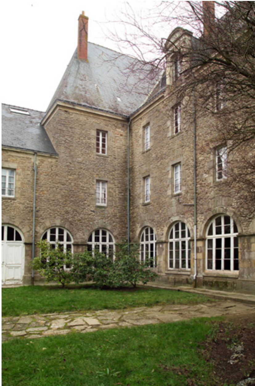
Angle intérieur nord-est.
