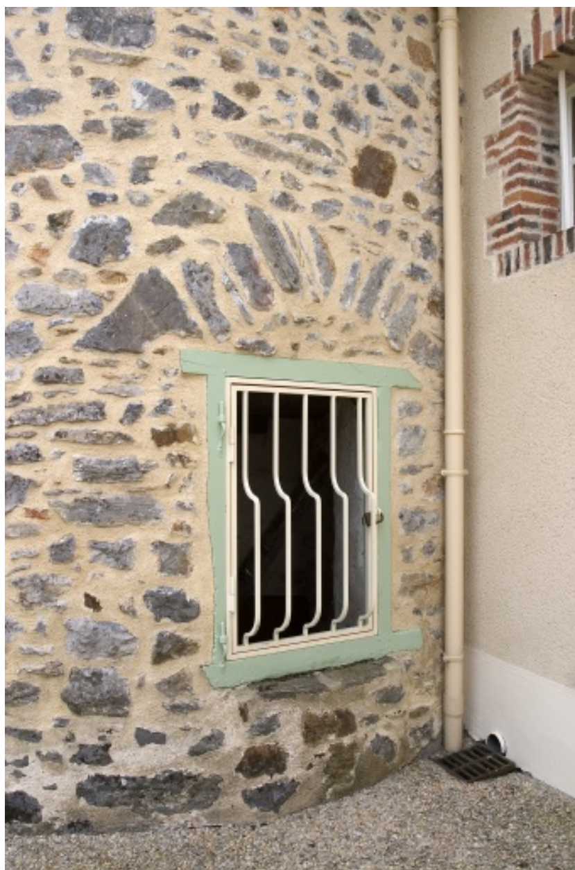
Porte (?) en partie bouchée de la tour.
