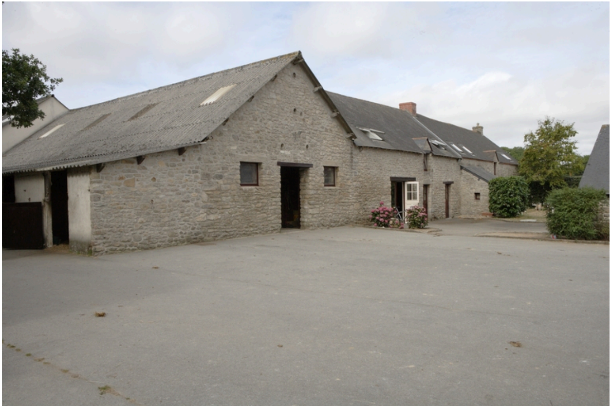
La métairie. Vue d'ensemble depuis le nord-est.
