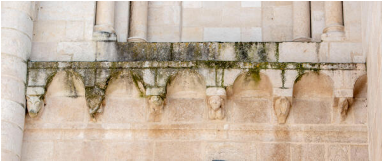
Corniche du premier niveau, partie gauche.
