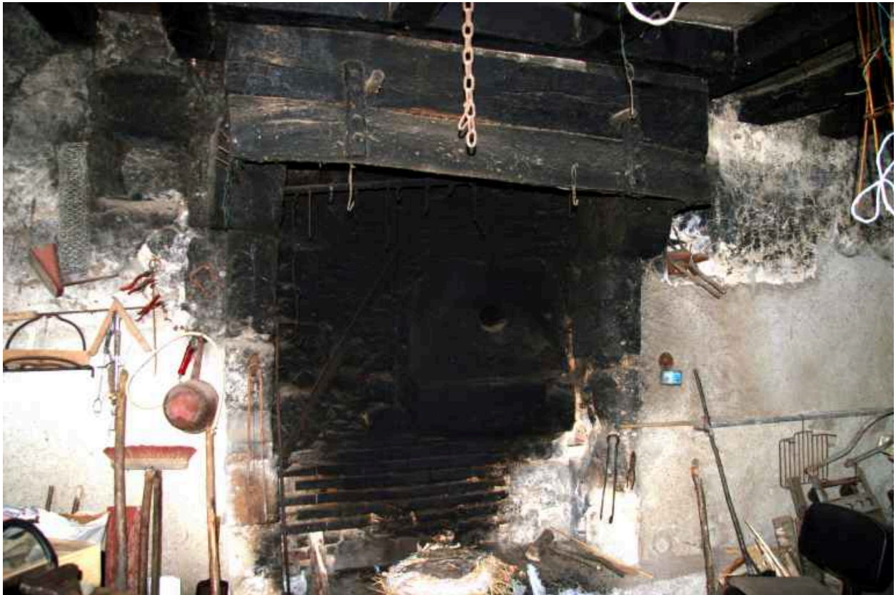
Vieille maison : cheminée et niche.
