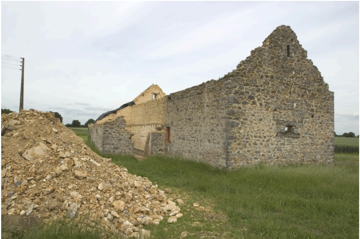
La façade postérieure du logis vue depuis l'ouest.
