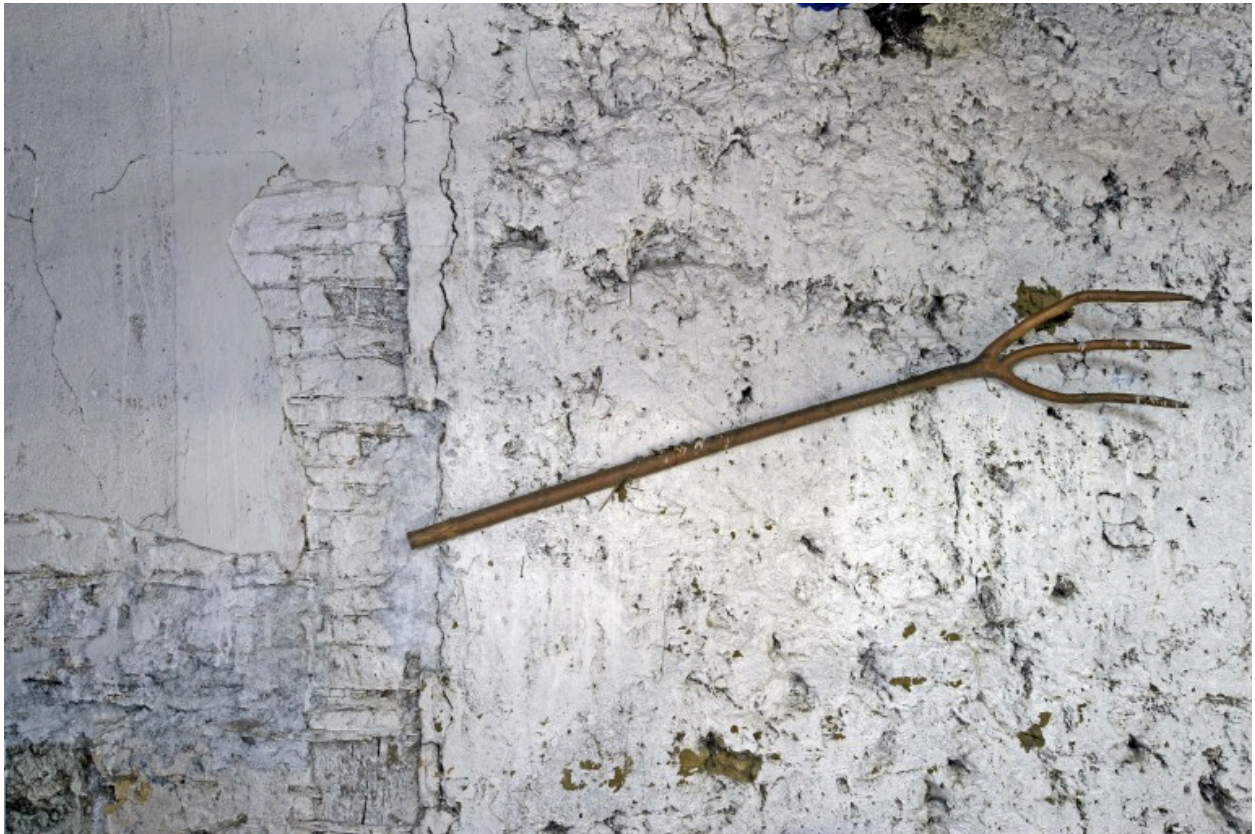
Fournil, intérieur : liaison entre le mur en bauge et le mur en pan de bois du logis.
