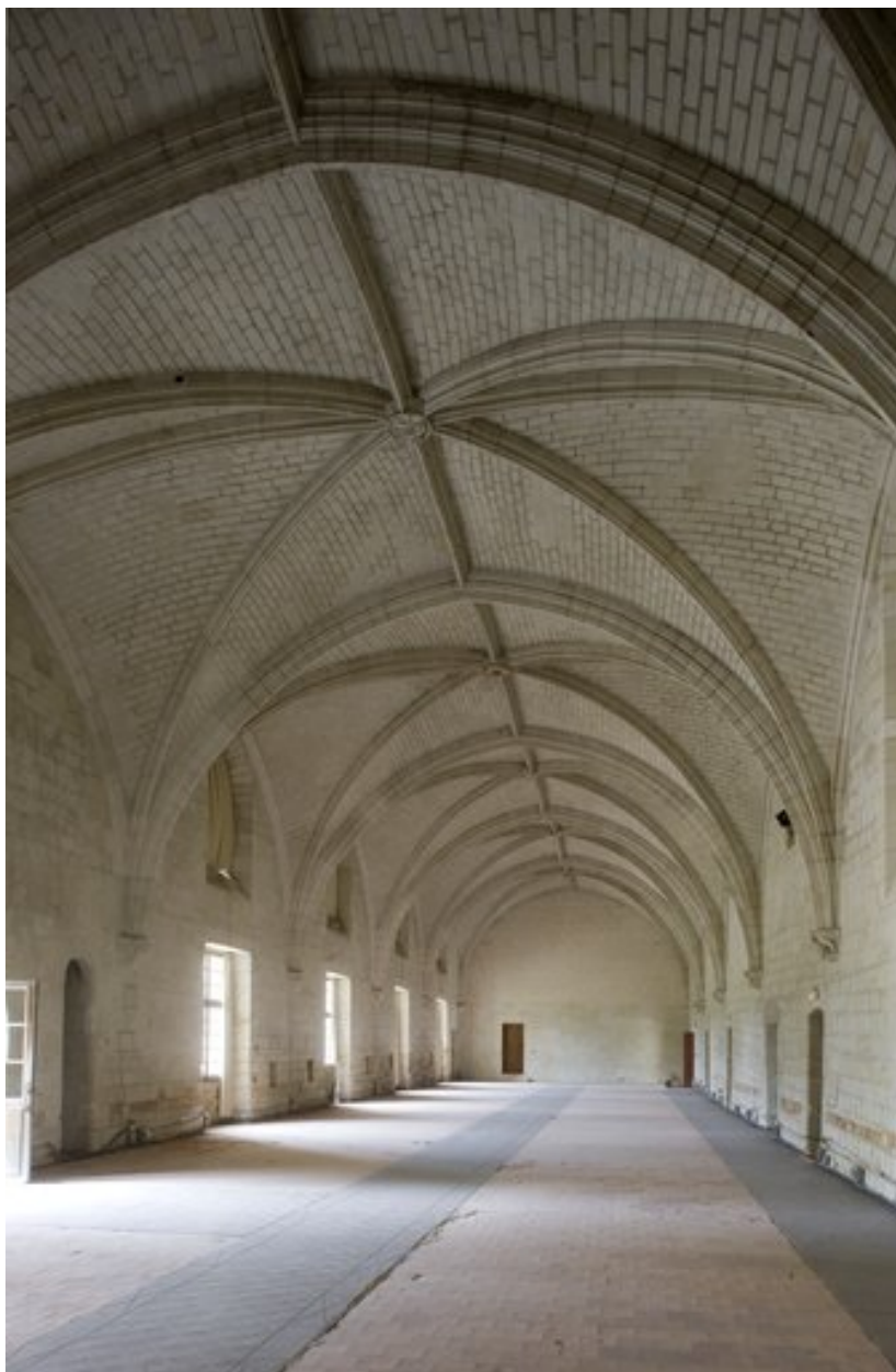
Aile sud du cloître, réfectoire, intérieur, couvrement (début XVI e siècle).
