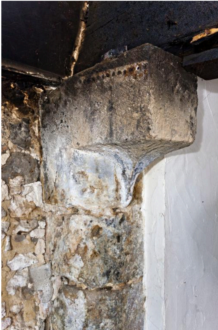
Console droite de la cheminée du logis de La Cocardière.
