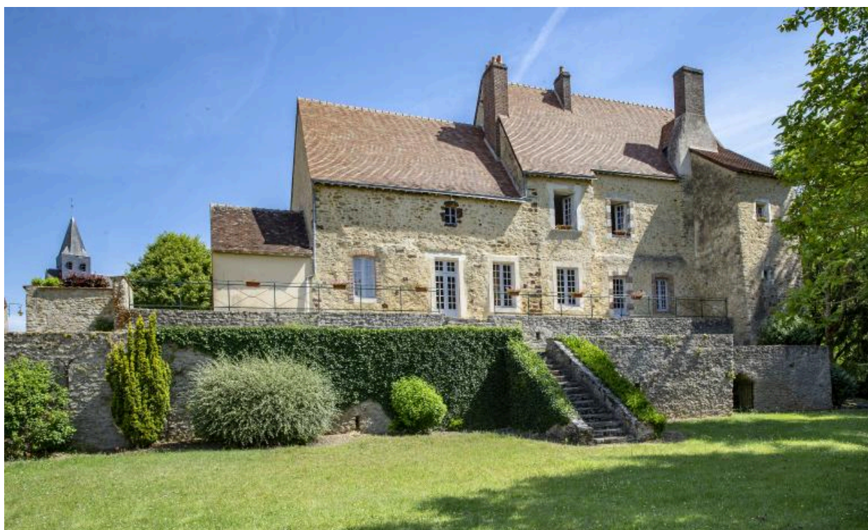
La façade postérieure.
