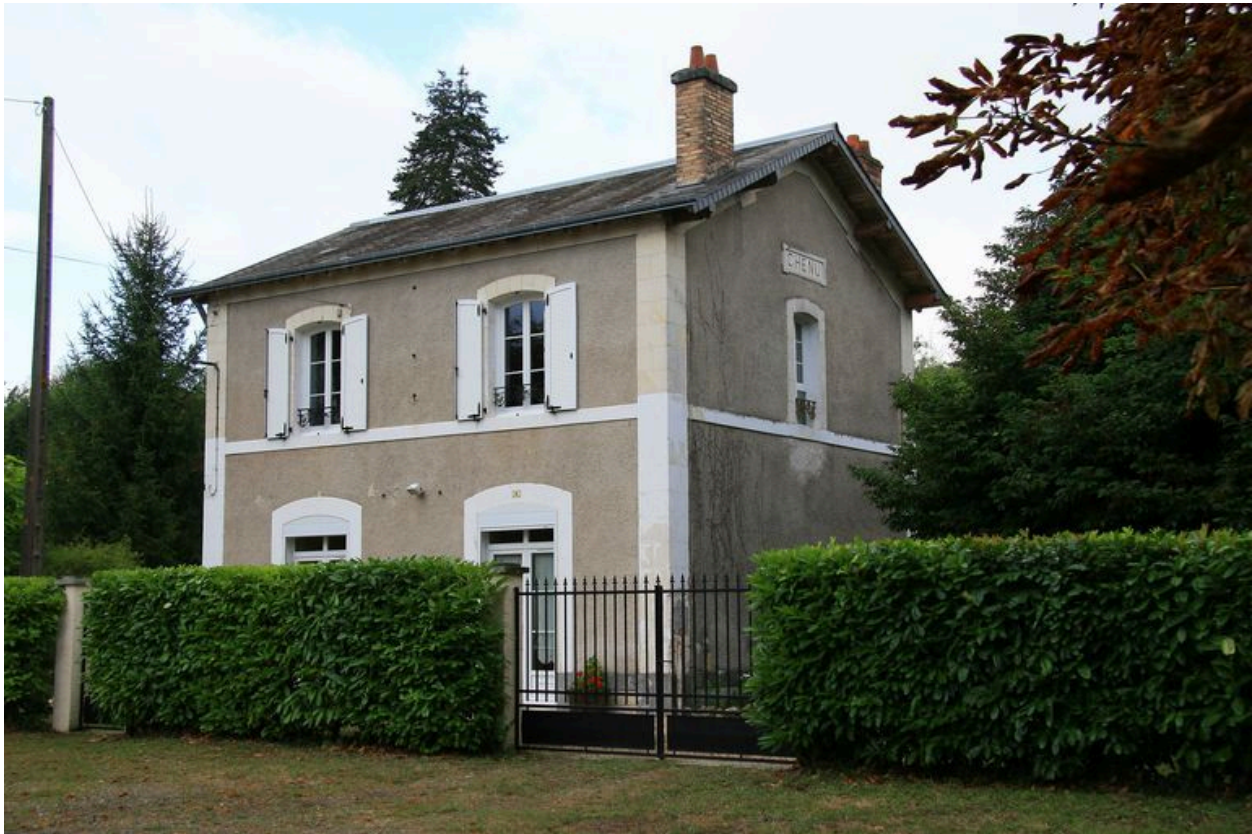
La gare : façade antérieure sur la place.
