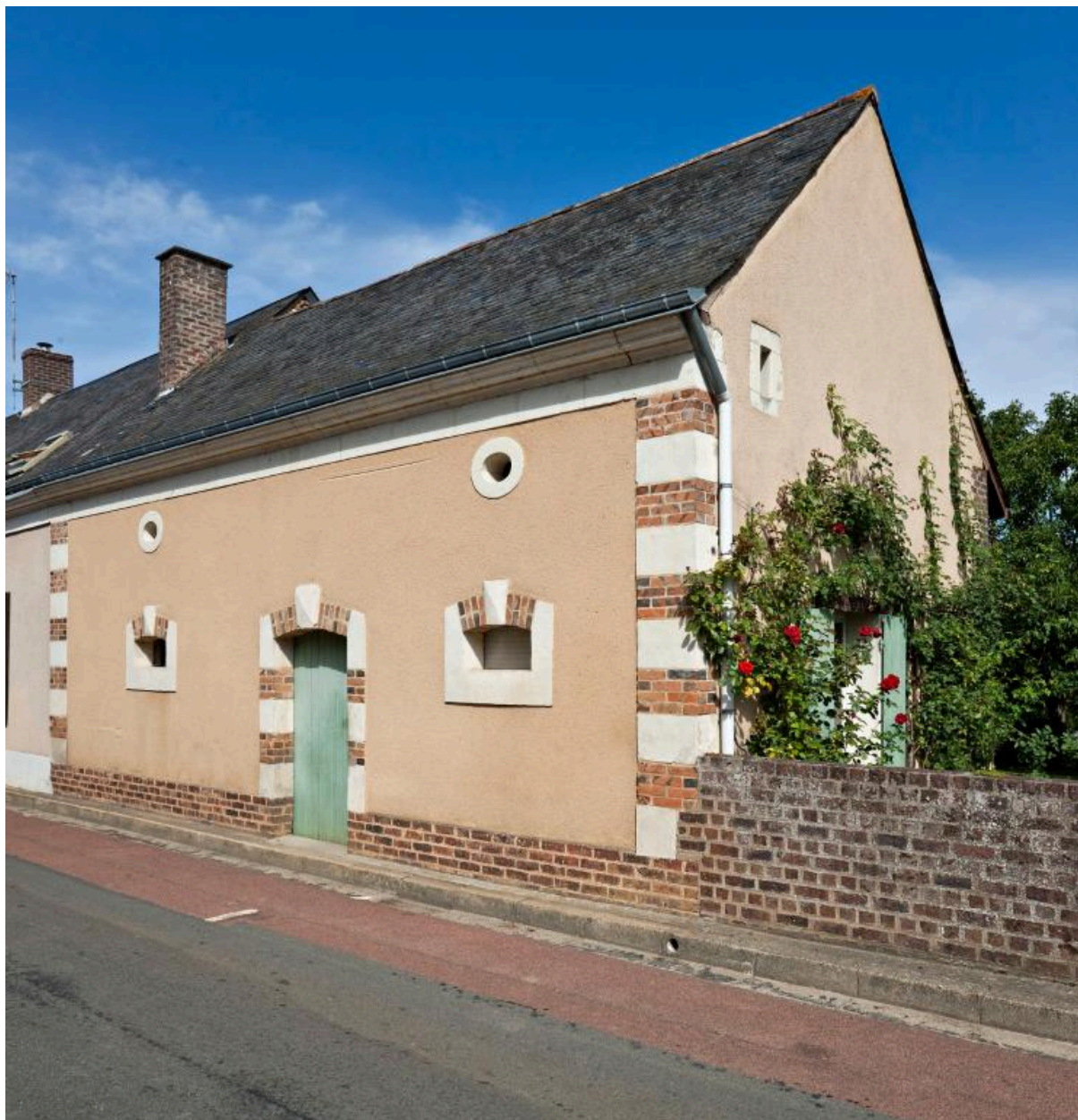
Grange-étable : façade sur rue.
