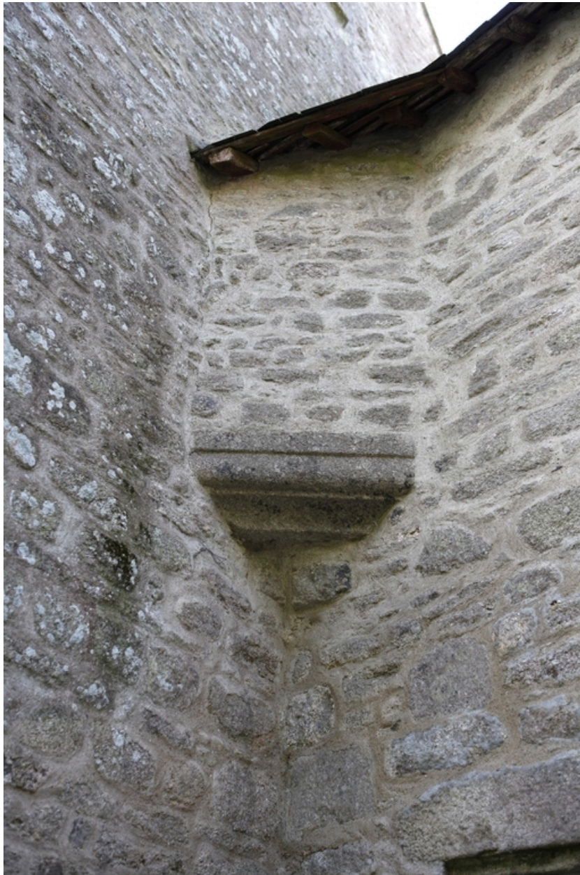
Logis. Angle nord-est. Passage en encorbellement entre la chambre et la garde-robe.
