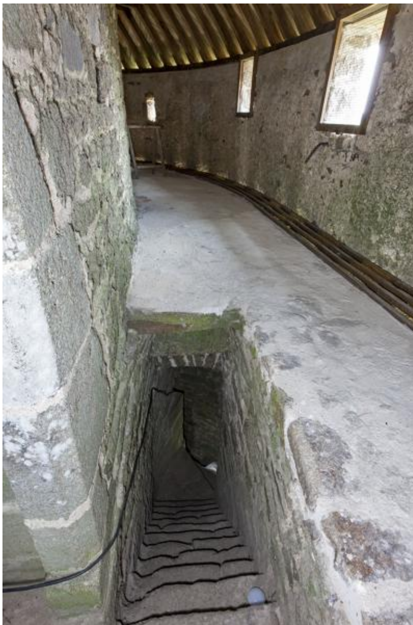
Escalier menant au chemin de ronde de la tour 5.
