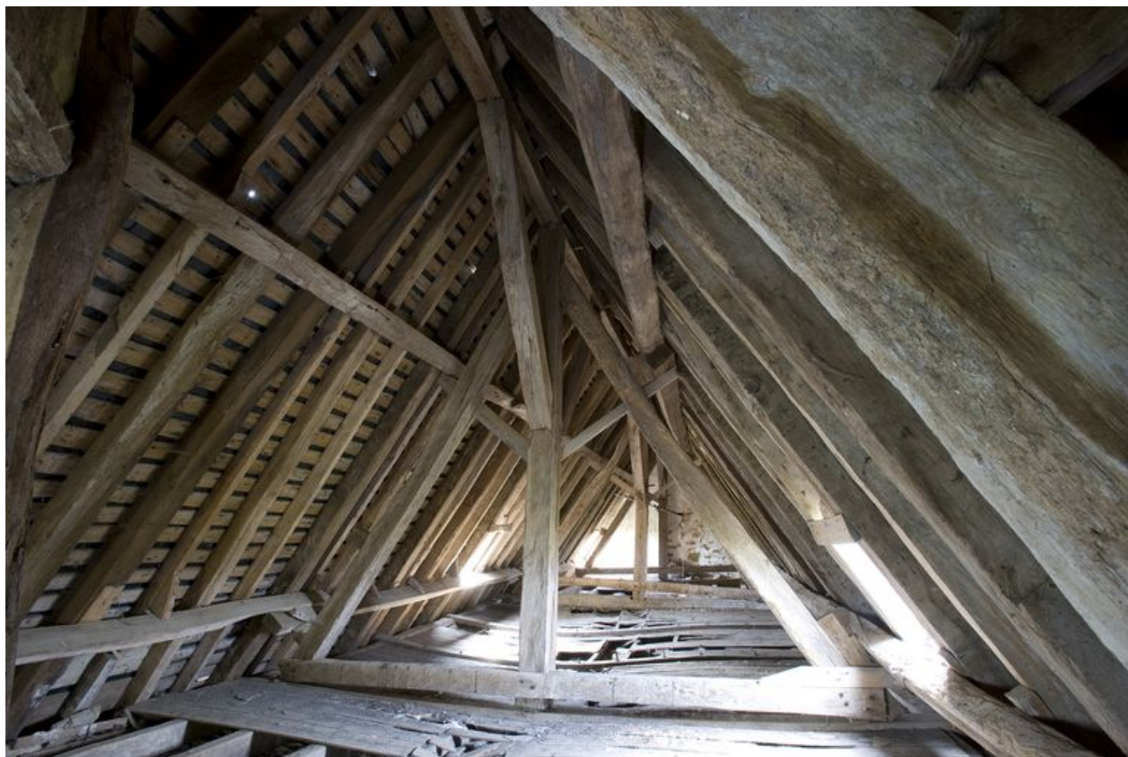
Intérieur du logis, partie est : la charpente vue depuis l'est.
