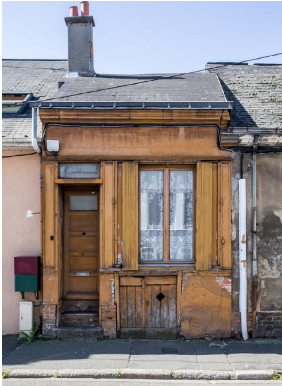
Vue d'une ancienne boutique rue Saint-Pavin.
