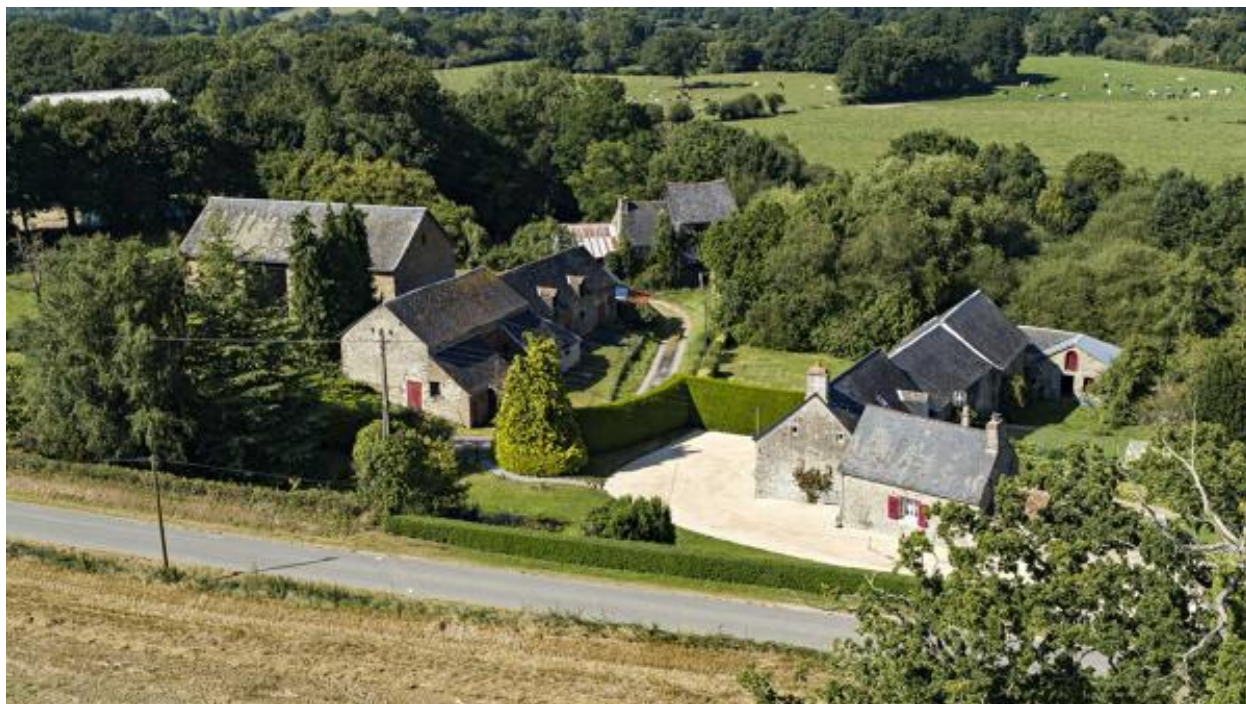
Vue aérienne depuis le nord-est
