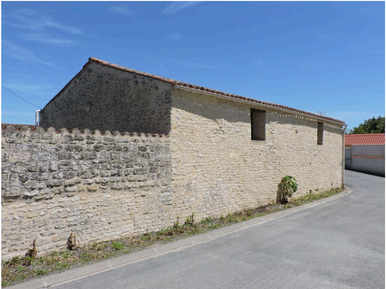
La maison et la dépendance qui la prolonge à l'arrière, vues depuis l'ouest.
