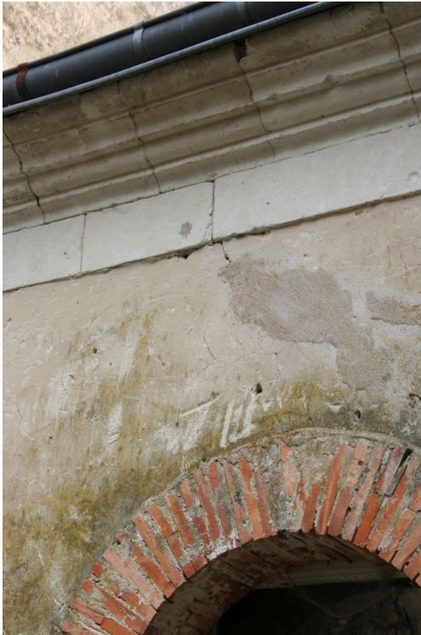
Petite annexe du pignon est, détail : arc plein cintre de la porte en brique chantignolle, corniche en tuffeau.
