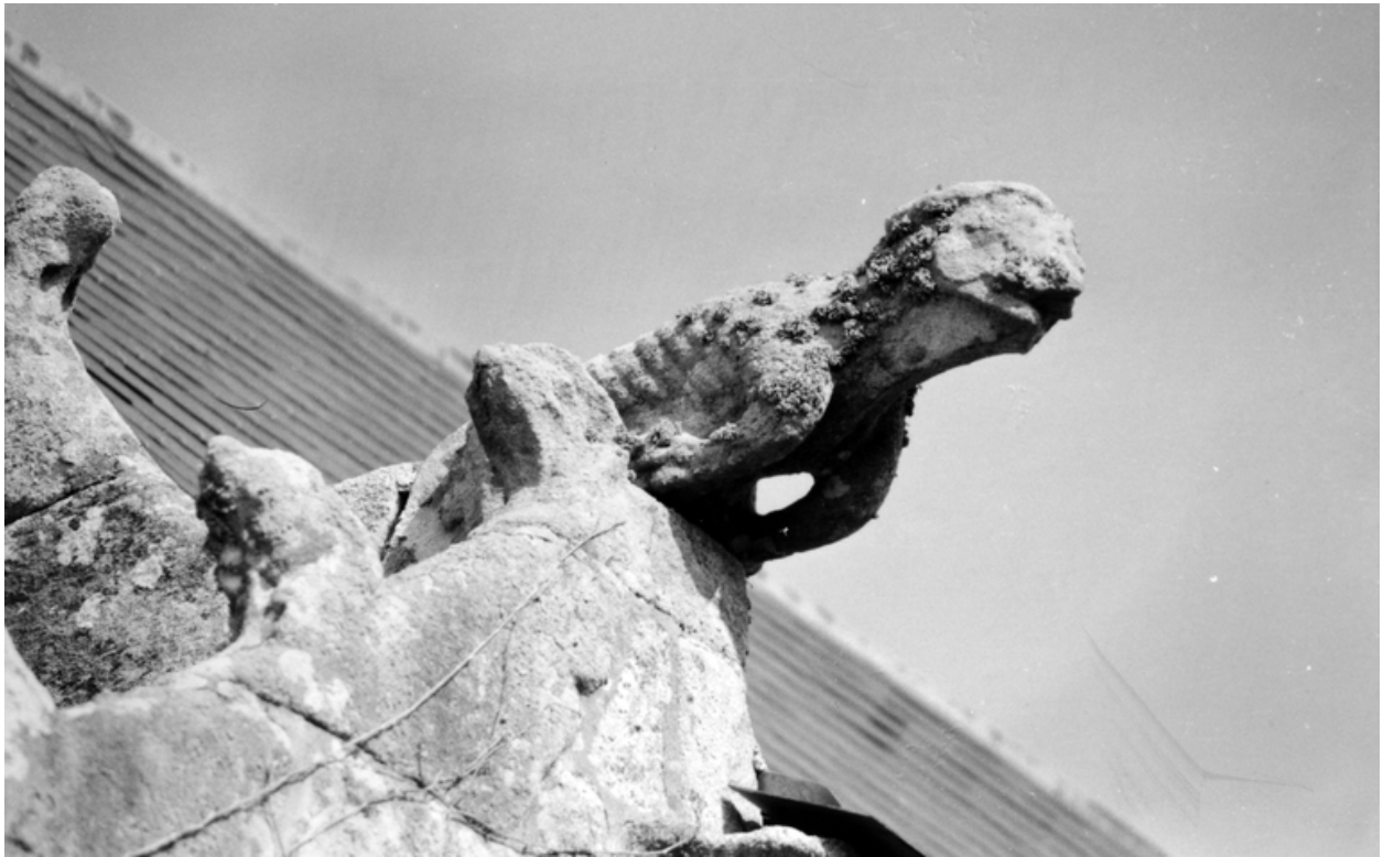
Détail d'une crossette sculptée sur le pignon ouest. 1990.
