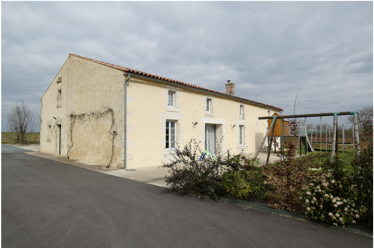
Le logis et les dépendances accolées vus depuis le sud-ouest.
