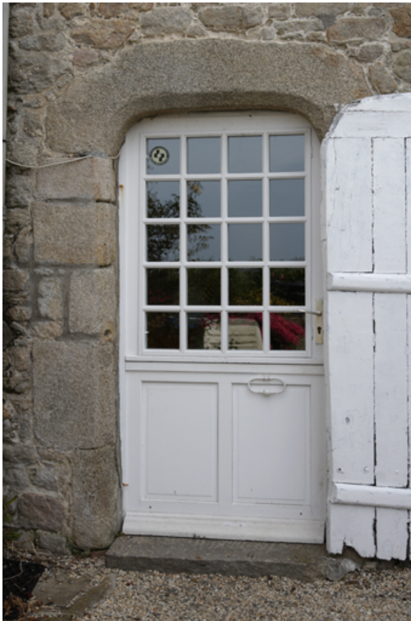
Logis. Pignon sud. Détail de la porte.
