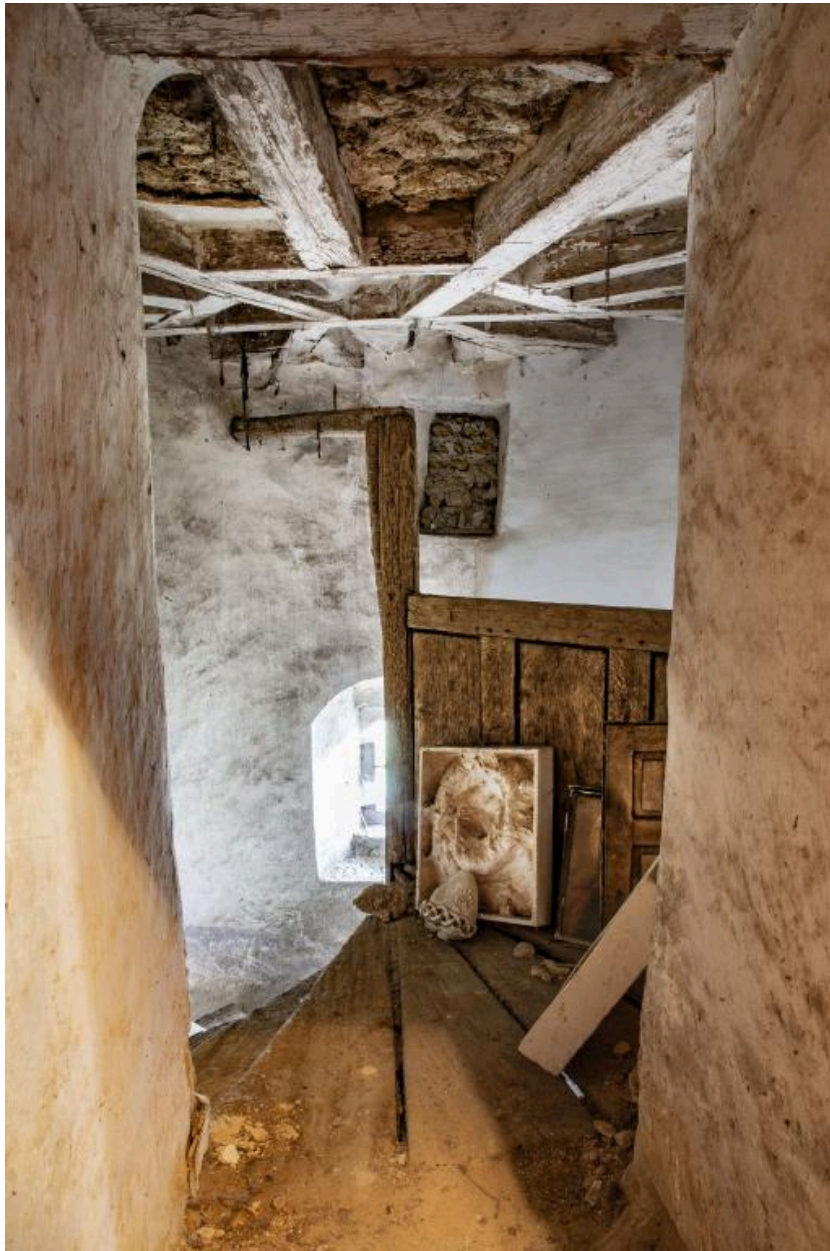
Le sommet de la tour d'escalier.
