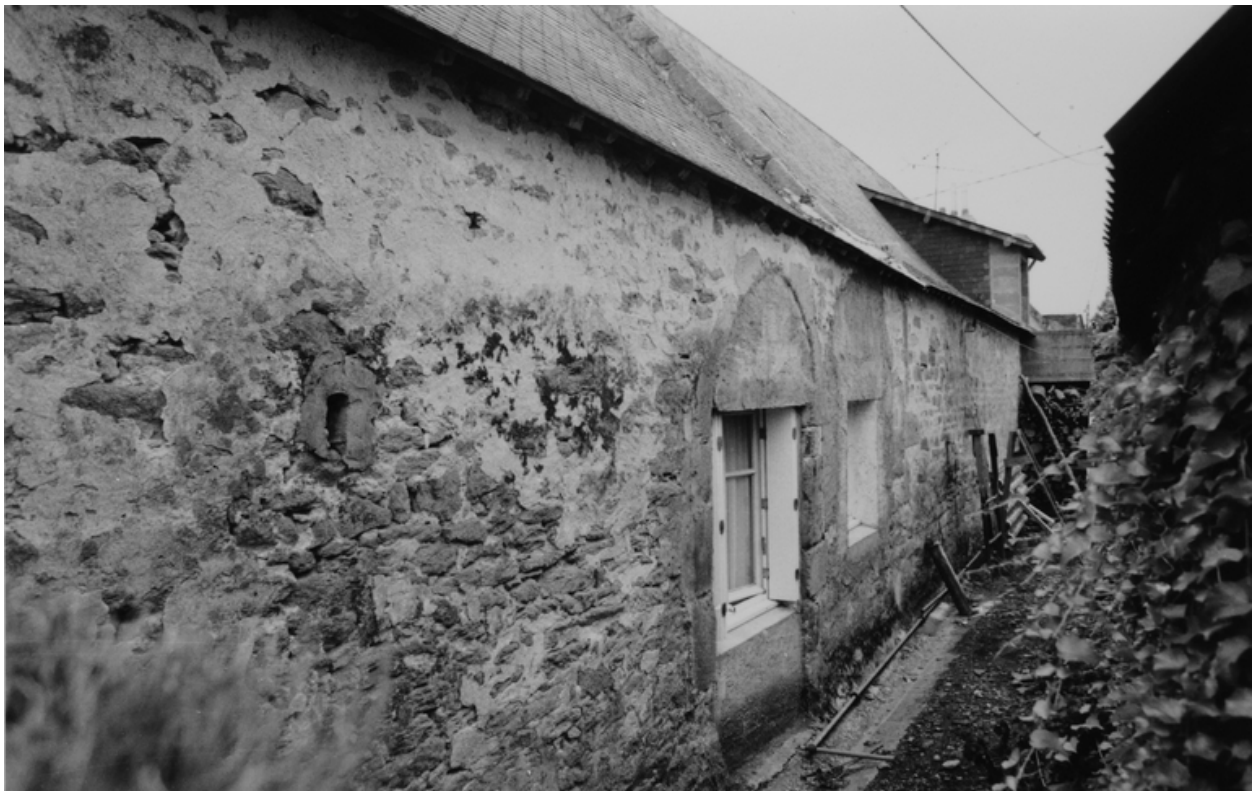
Vue de la façade nord depuis l'est.
